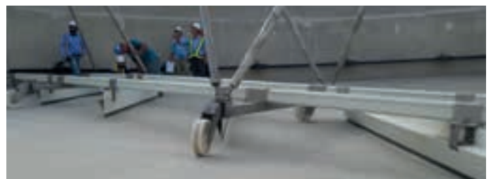
A kioldó rendszert a hab mennyisége szerint lehet beállítani: akár a nyitókapu magasságát a kotróelem közeledése előtt, akár a nyitási idő hosszát.
