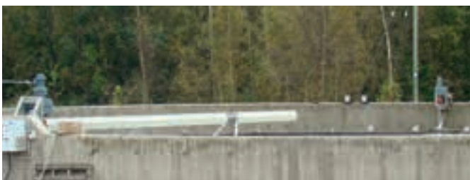
A szabadalmaztatott habgyűjtő doboz elején habkapu található, amely leállítja a vízáramlást, amikor a kotróelem nincs a habgyűjtő doboz közelében.
